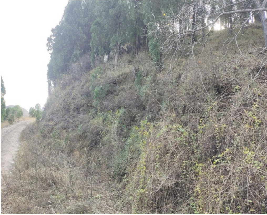
图 4-24 长清区灵岩山陡坡地禁垦区 2 近景照
