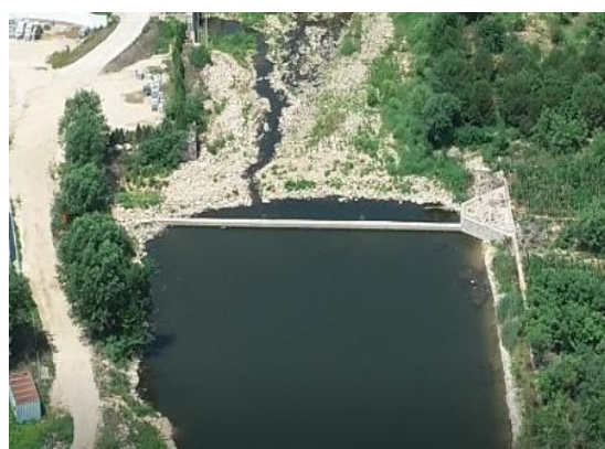
西张峪拦河坝 3
