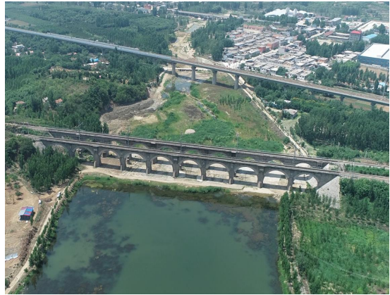
津浦铁路桥、京沪铁路桥
